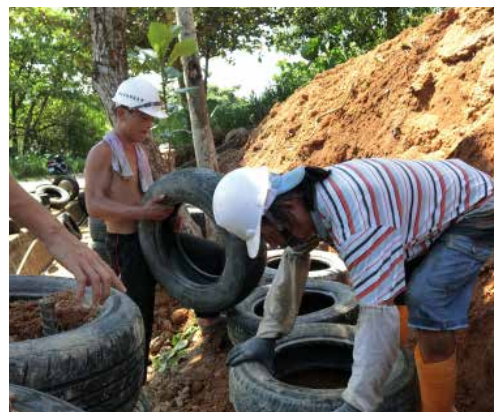
輪胎擋土牆施作中（國際示範區，2018）
