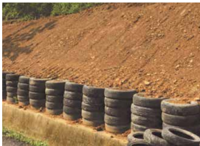
剛設置完成的輪胎擋土牆（國際示範區，2018）
