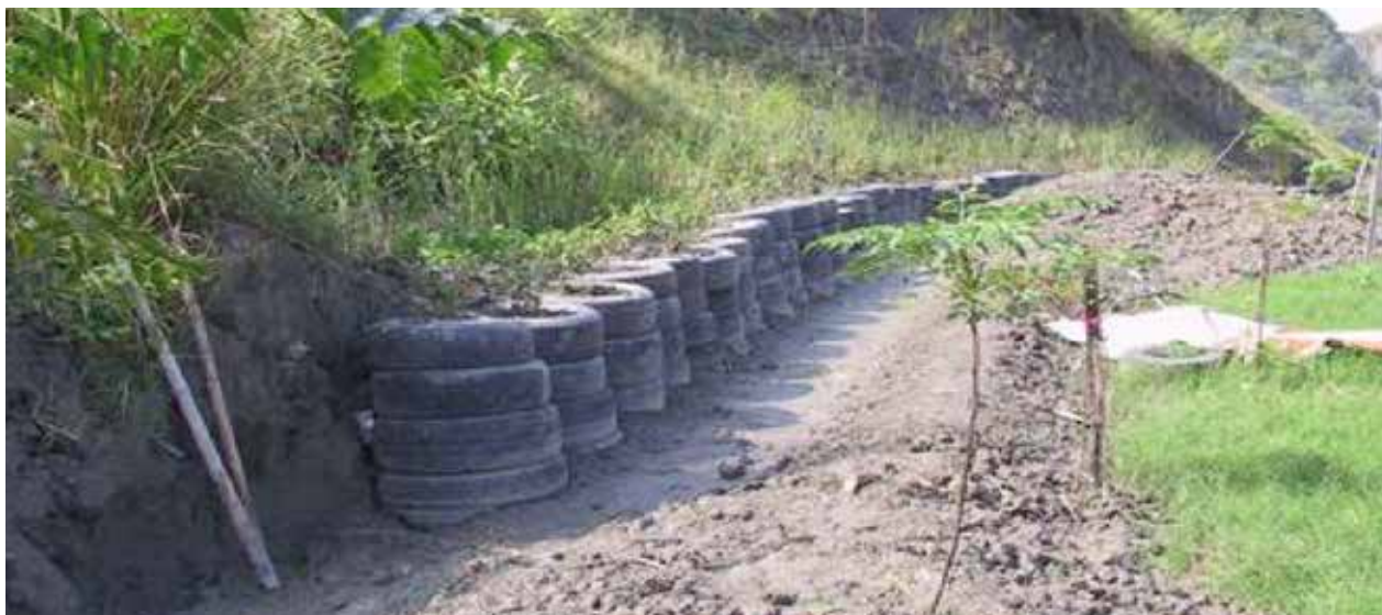
輪胎擋土牆（龍崎牛埔泥岩水保戶外教室，張文章）
