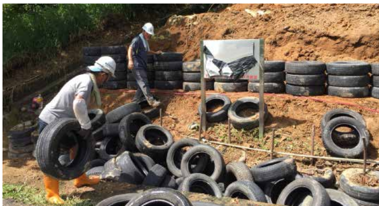
輪胎擋土牆施作中（國際示範區，2018）
